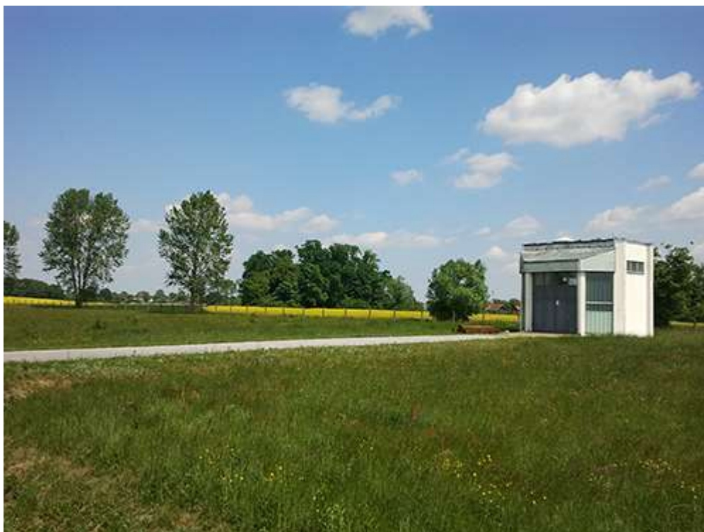
Slika 5 Vodocrpilište u Delovima
