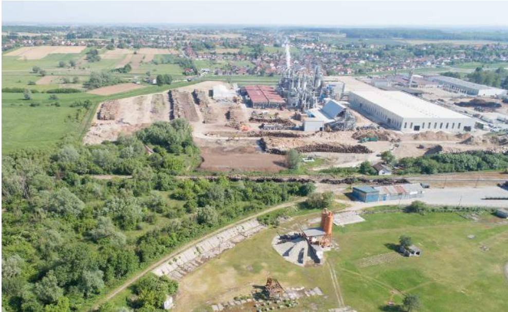
Fotografija 79 Industrijska zona tvrtke Kronospan CRO d.o.o. (Autori: Andlar i 3E PROJEKTI d.o.o.)
