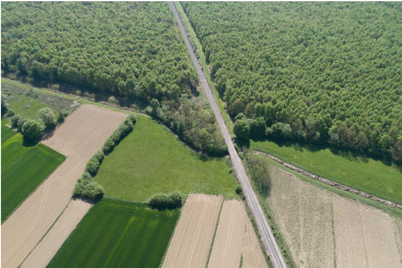
Fotografija 88 Detalj trase željeznice unutar šumskih i poljoprivrednih površina (Autori: Andlar i 3E PROJEKTI d.o.o.)
