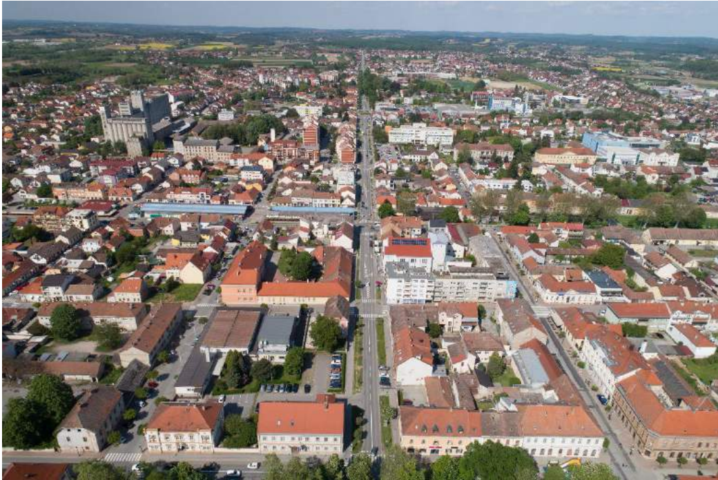
Fotografija 53 Blokova gradnja u gradskom središtu (Autori: Andlar i 3E PROJEKTI d.o.o.)
